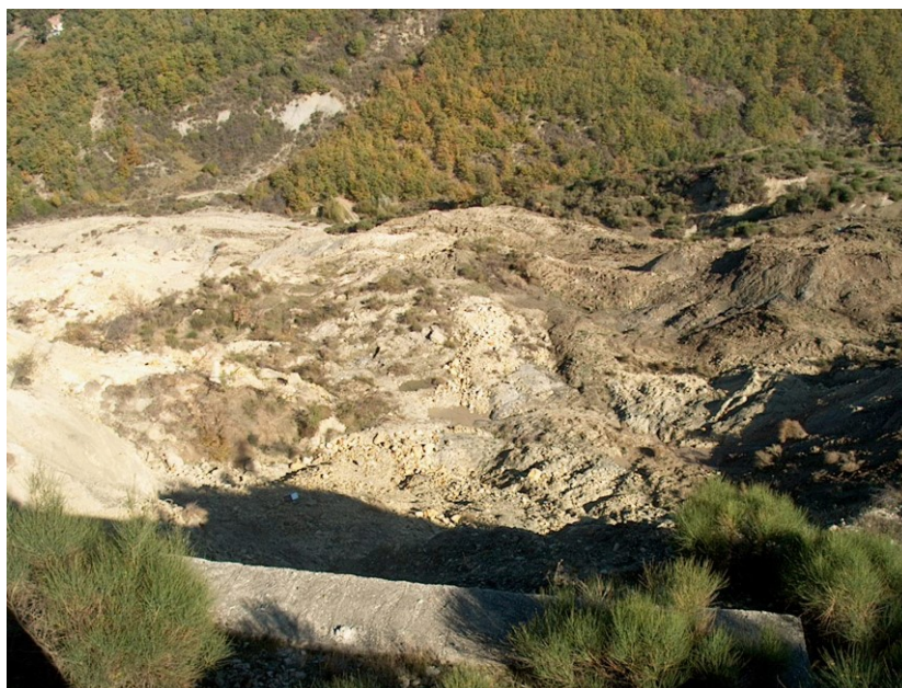
Fig. 09 – Evoluzione frana in Località Trono – S.S. 92 (foto Priore. 2003)
