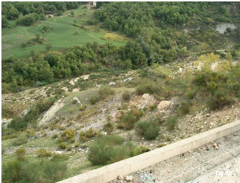
Fig. 08 – Frana in Località Trono – S.S. 92 (foto Priore. 2002)
